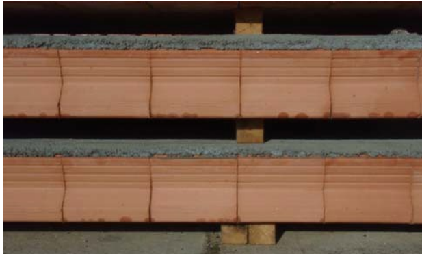
Kép: A tömb első panelét két alátéttel támasszuk alá
