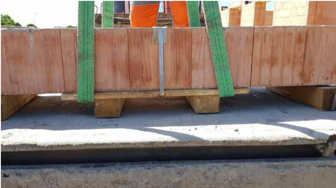
Kép: Példa az áthidaló helyes mozgatására – a heveder/pánt átvezetése a mozgatást segítő raklapon.
