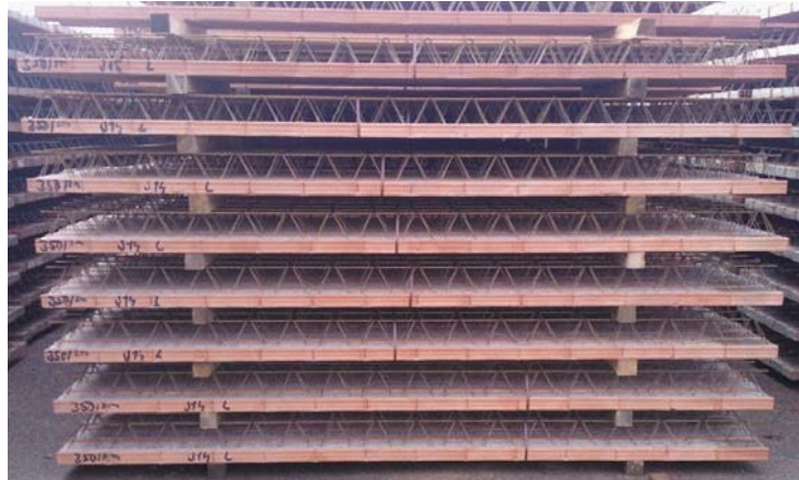
Ábra: Az alátétek megfelelő elhelyezése 7. kép: Példa födémgerendák lerakatára
