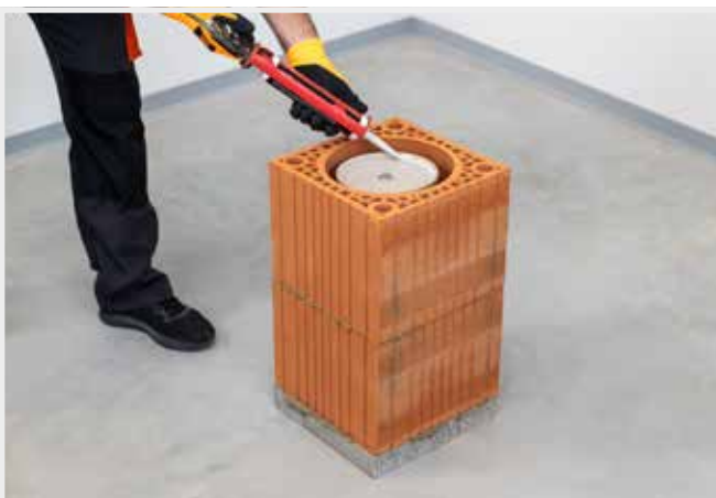
TÖMÍTŐMASSZA FELHORDÁSA AZ ELVEZETŐRE
