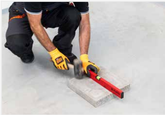
AZ ALAPLAP VÍZSZINTBE IGAZÍTÁSA
