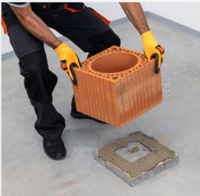
AZ ELSŐ KÉMÉNYIDOM FELHELYEZÉSE ÉS PONTOS VÍZSZINTEZÉSE
