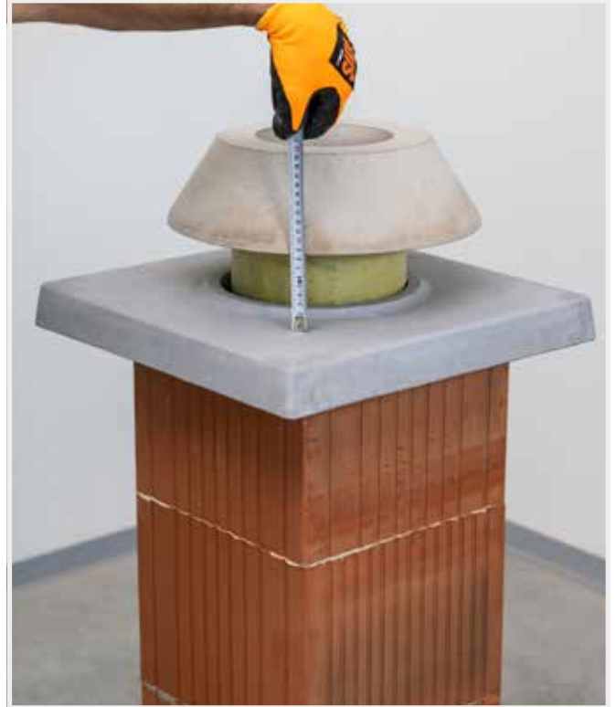
AZ UTOLSÓ BÉLÉSEM SZÜKSÉGES RÖVIDÍTÉSÉNEK MÉRÉSE
