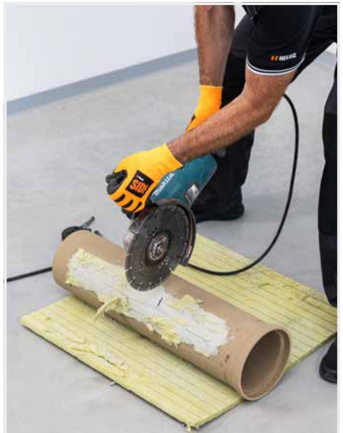
A BÉLÉSEK VÁGÁSA SAROKCSISZOLÓVAL, A MEGFELELŐ KORONGGAL TÖRTÉNIK
