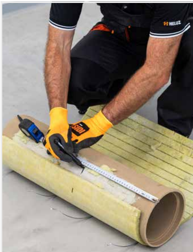
A BÉLÉS VÁGÁSÁNAK LEHETŐSÉGE A KÍVÁNT MAGASSÁG BIZTOSÍTÁSÁHOZ
