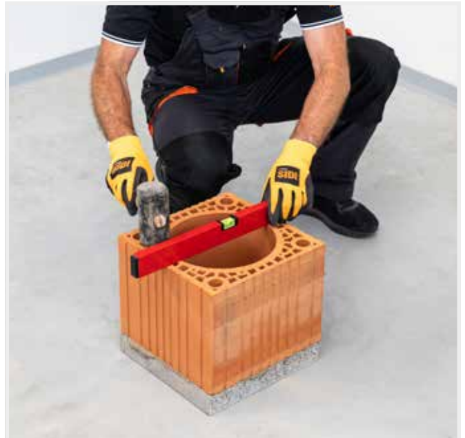
AZ ELSŐ KÉMÉNYIDOM FELHELYEZÉSE ÉS PONTOS VÍZSZINTEZÉSE
